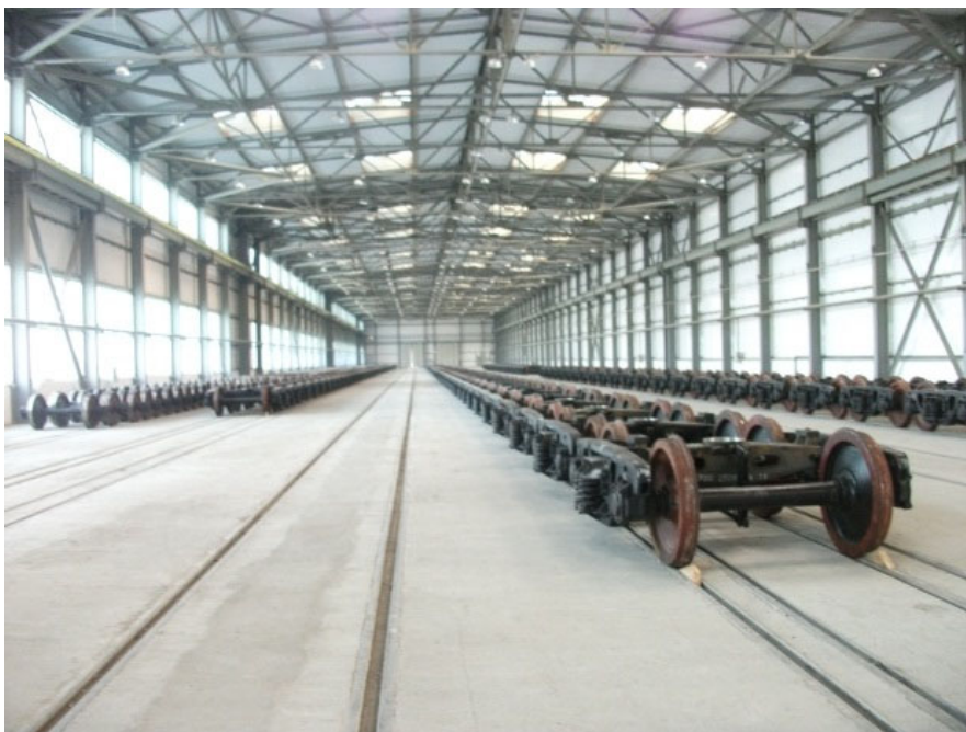
Рис.2. Склад вагонных тележек
