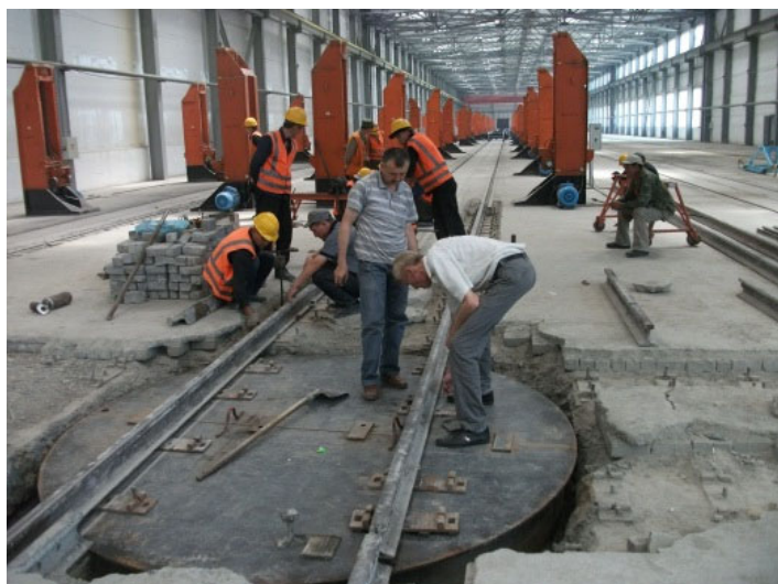
Рис.11. Установка рельсов на поворотный круг
