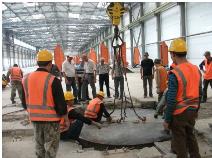
Рис.10. Монтаж поворотного круга
