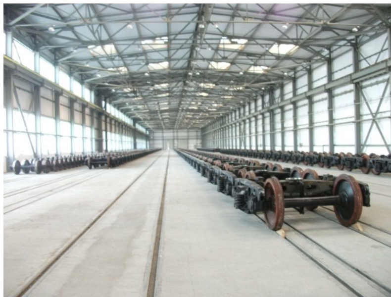
Рис.2. Склад вагонных тележек
