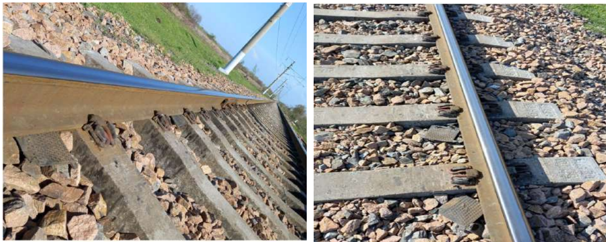
Рисунок 2 – Основные недостатки подрельсовых прокладок типа Pandrol Fastclip в железнодорожной линии
