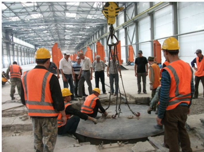
Рис.10. Монтаж поворотного круга
