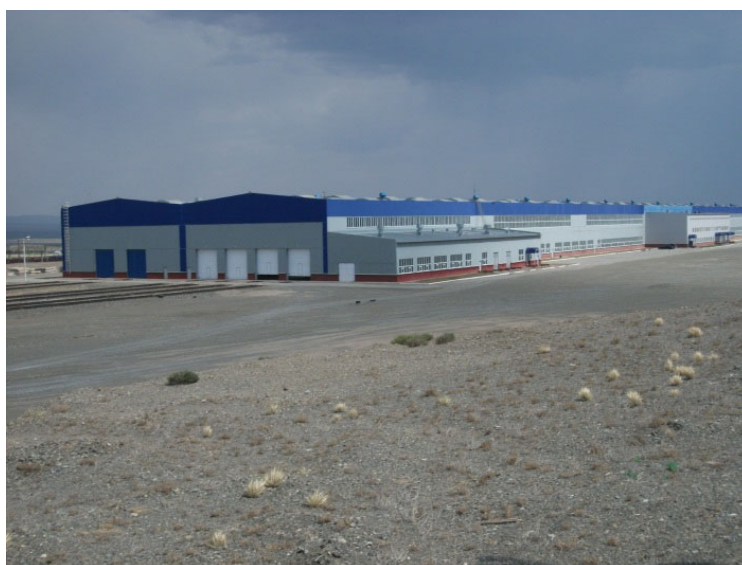
Рис.1. Пункт перестановки вагонов
