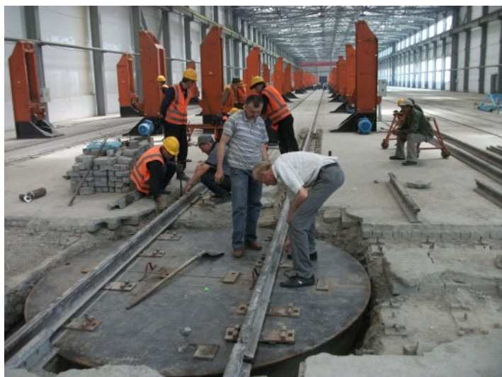
Рис.11. Установка рельсов на поворотный круг
