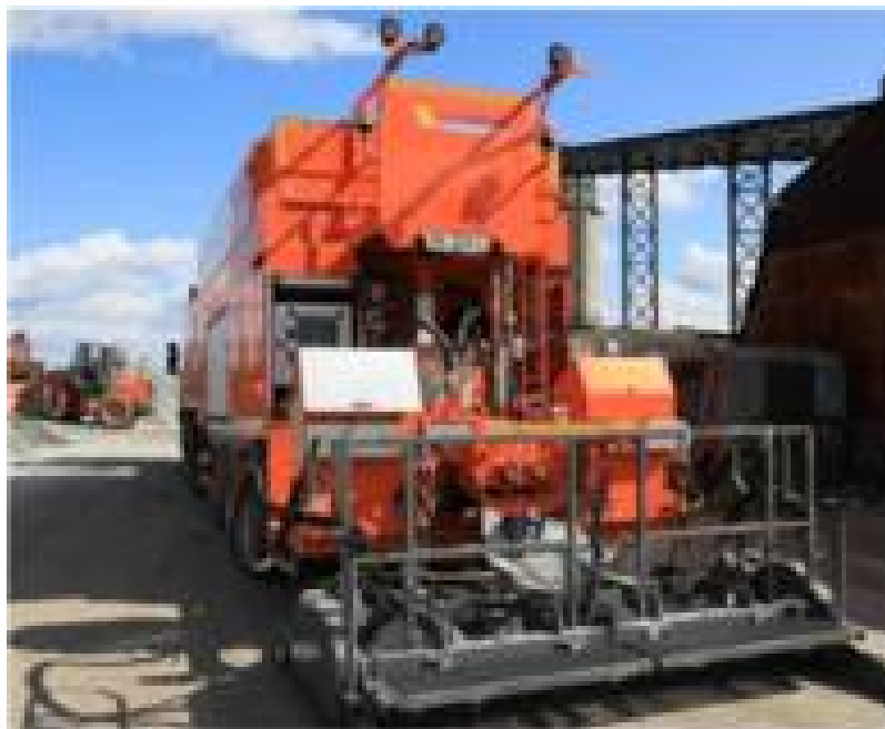
Рисунок 4 – Мобильный самоходный укладочный комплекс для устройства покрытий из смесей СларриСил или Микросюрфейсинга
