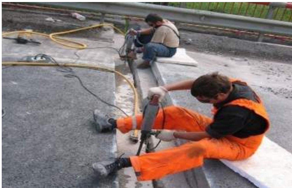
Рисунок 2 – Подготовка поверхности штрабы
