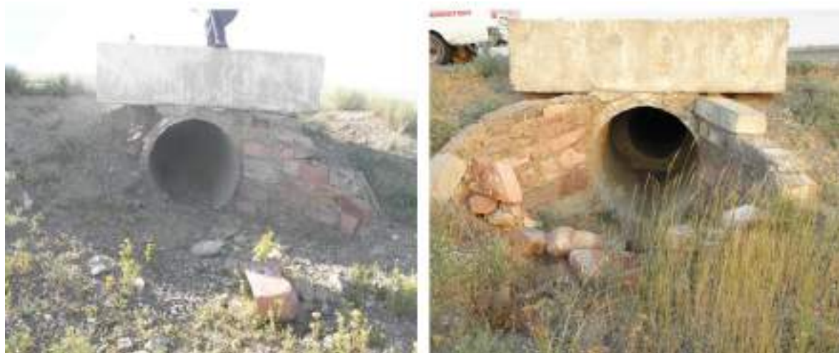
Рисунок 1 – Водопропускная труба диаметром 1 м, км 12+390
